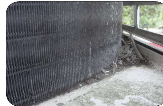
熱交換器下部の腐食
