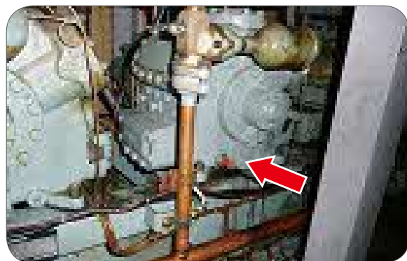
圧縮機周辺の油のにじみ状況
