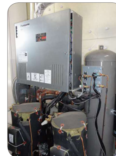
機械室内部にある冷凍機
