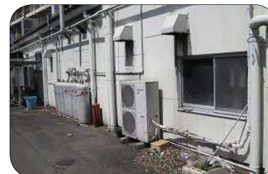
室外環境異常による配管の劣化
