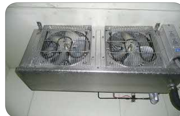
冷蔵庫内正常な冷却器外観
