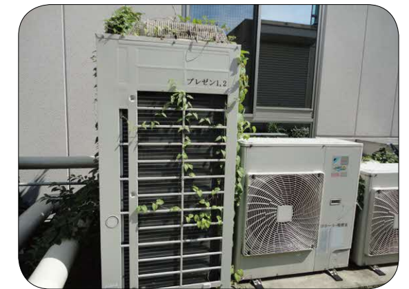
草で覆われた室外機
