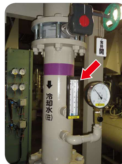
冷却水入口温度計確認
