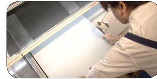
床板を外します
