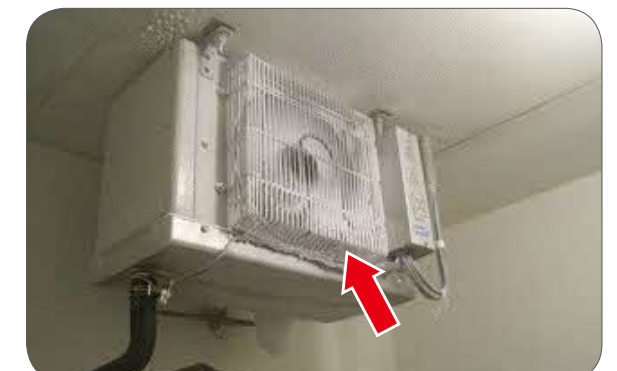
冷却器の内部霜付き異常
