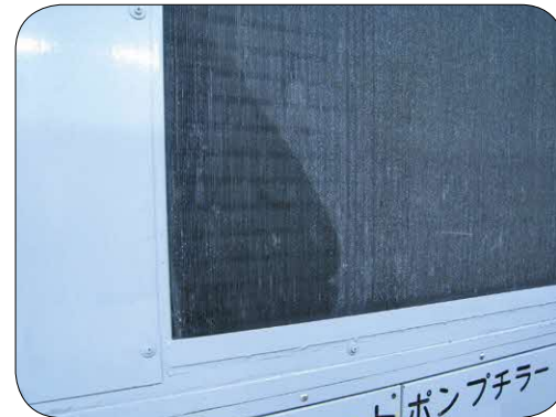
熱交換器の油のにじみ
