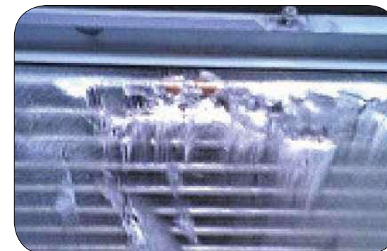
熱交換器表面の損傷
