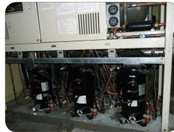
ユニット型冷凍機の異常振動確認
