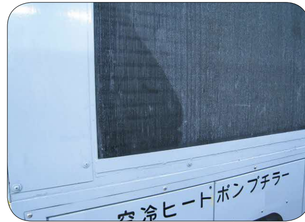
熱交換器の油のにじみ
