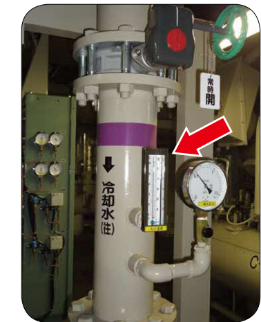
写真-E 冷却水入口温度
