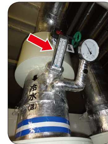
写真-D 冷水入口温度
