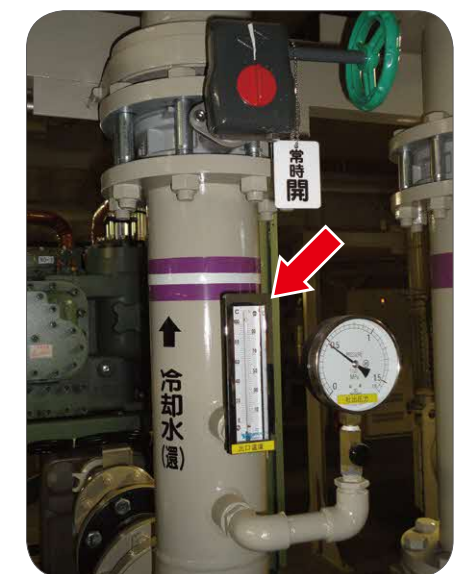
冷却水出口温度計確認
