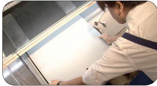
ショーケースの床板をはずします。
