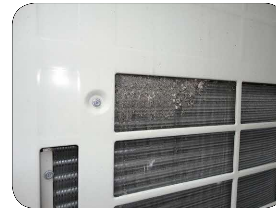
室外機に付着したゴミ
