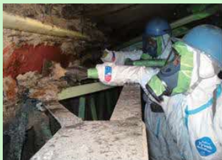
吹付け石綿の除去作業の様子
