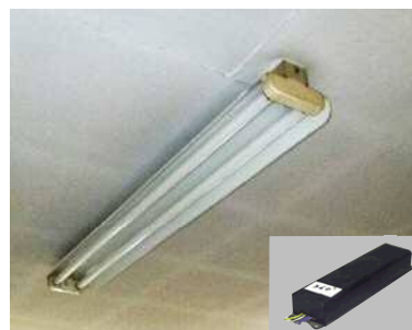
業務用照明器具の安定器
