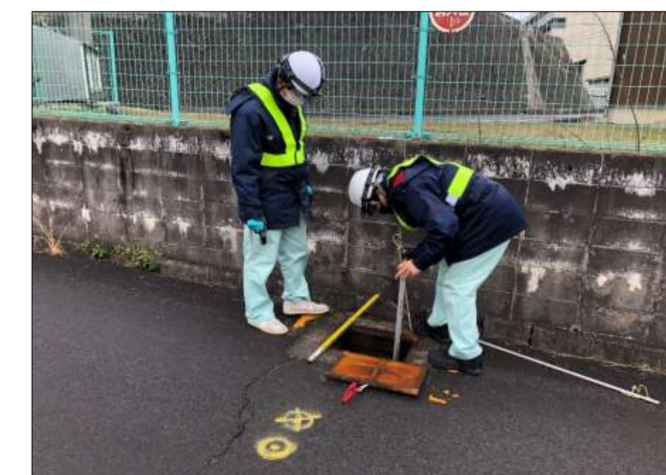
管路点検(飯梨川)
