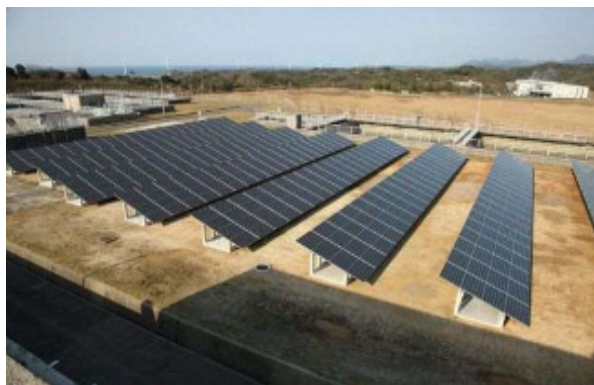
江津浄水場太陽光発電所
