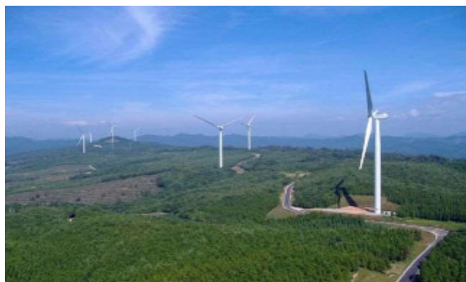
江津高野山風力発電所
