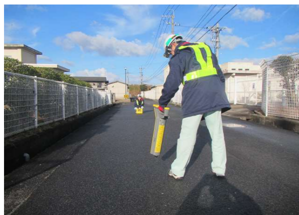
送水管芯出し作業(埋設送水管の中心を特定)
