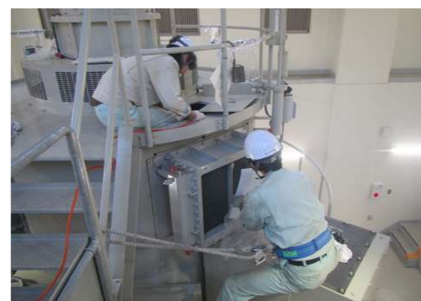
三成発電所停電作業(技術力継承)
