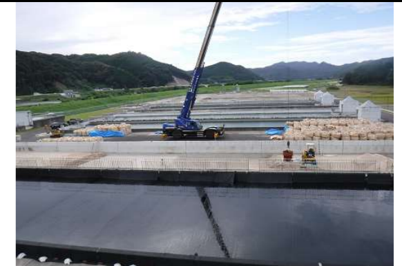
緩速ろ過池補砂工事
