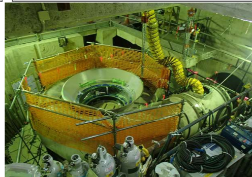
八戸川第一発電所リニューアル工事
