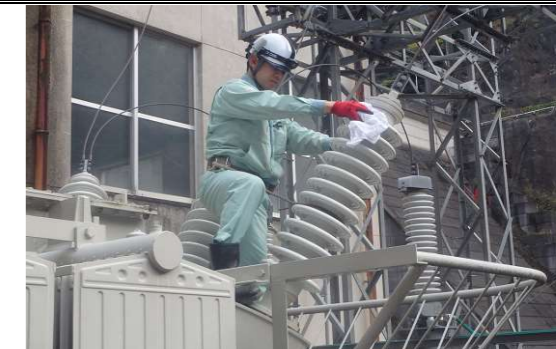
八戸川第二発電所停電作業
