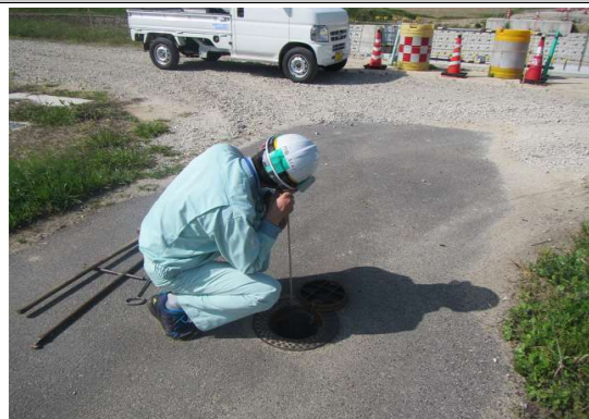
送水管路漏水状況確認作業
