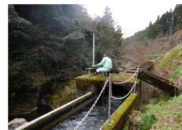
矢原川発電所水路点検(ダム水路主任技術者)
