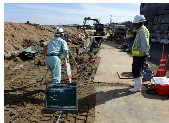
送水管路布設替工事
