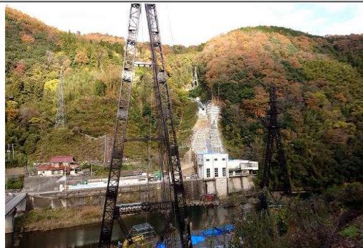
三隅川発電所リニューアル工事
