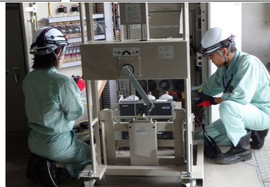
電気設備停電作業
