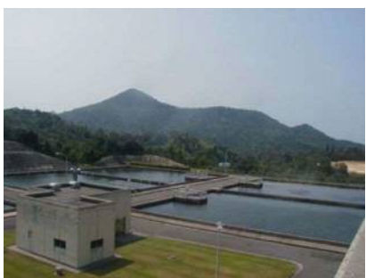
江津浄水場（江津市）
