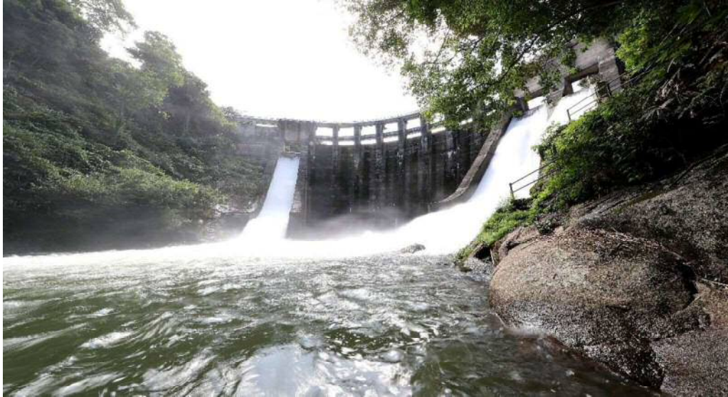
企業局管理ダム：土木遺産 三成ダム（奥出雲町三成）
