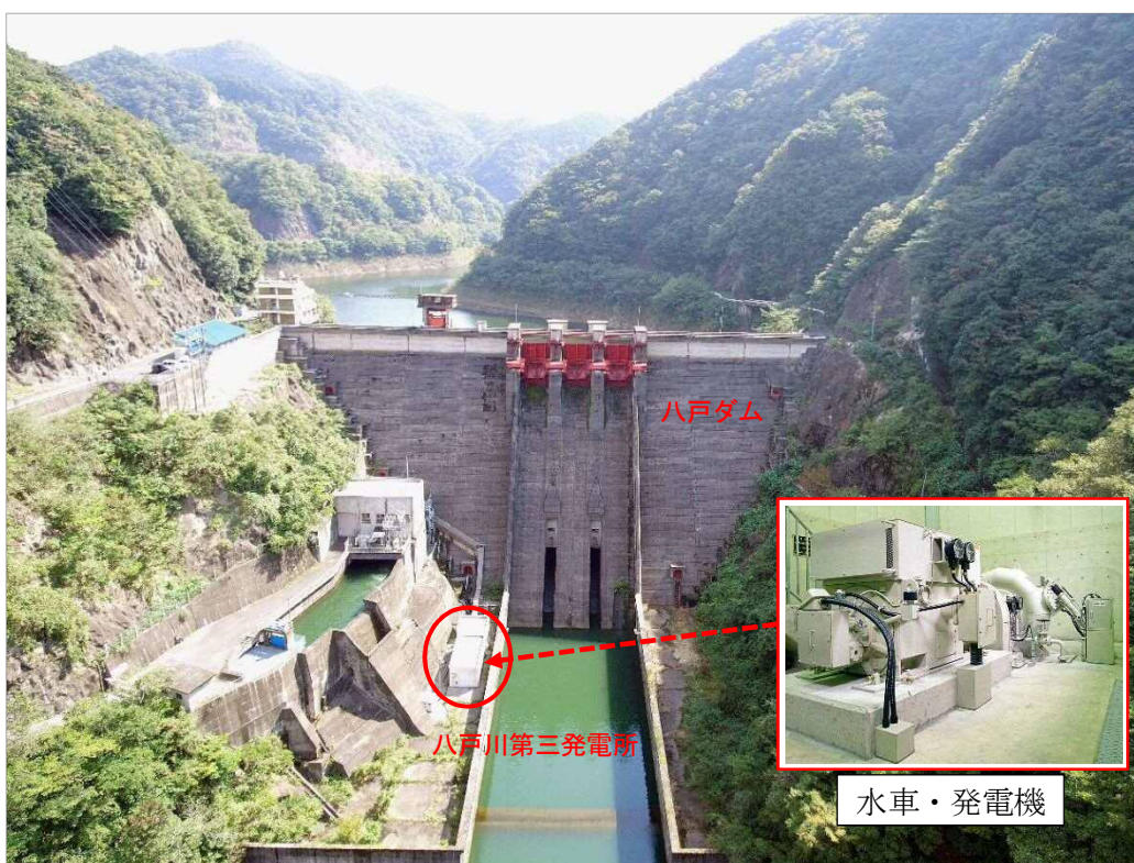
(4)八戸川第三発電所（現地着工前:令和6年3月運転再開予定）
