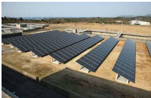
江津浄水場太陽光発電所
