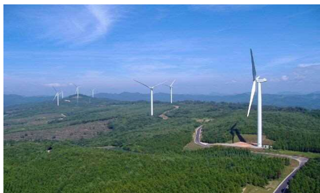
江津高野山風力発電所
