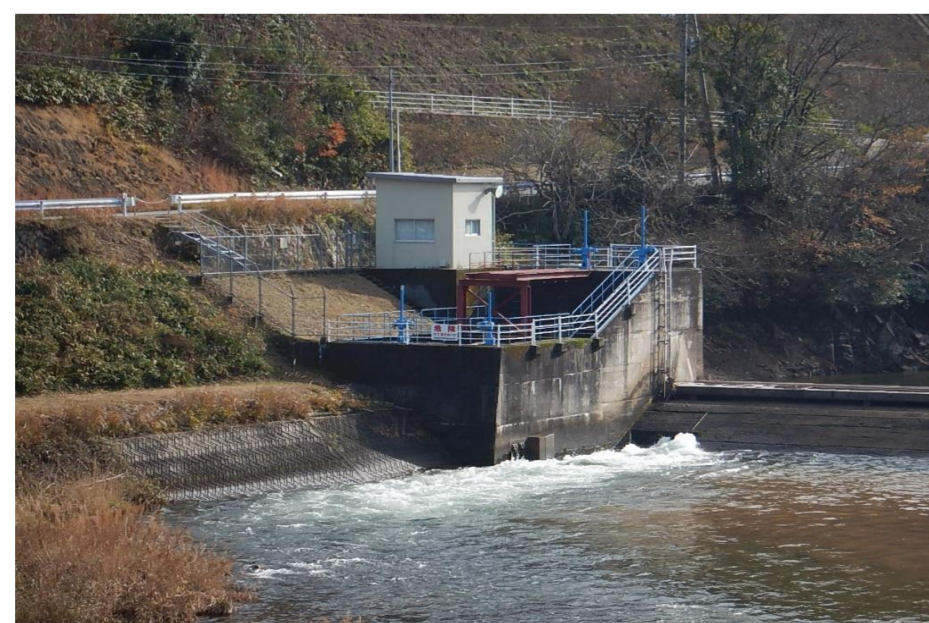
逆調整池 (右岸分水路: 飯梨川)
