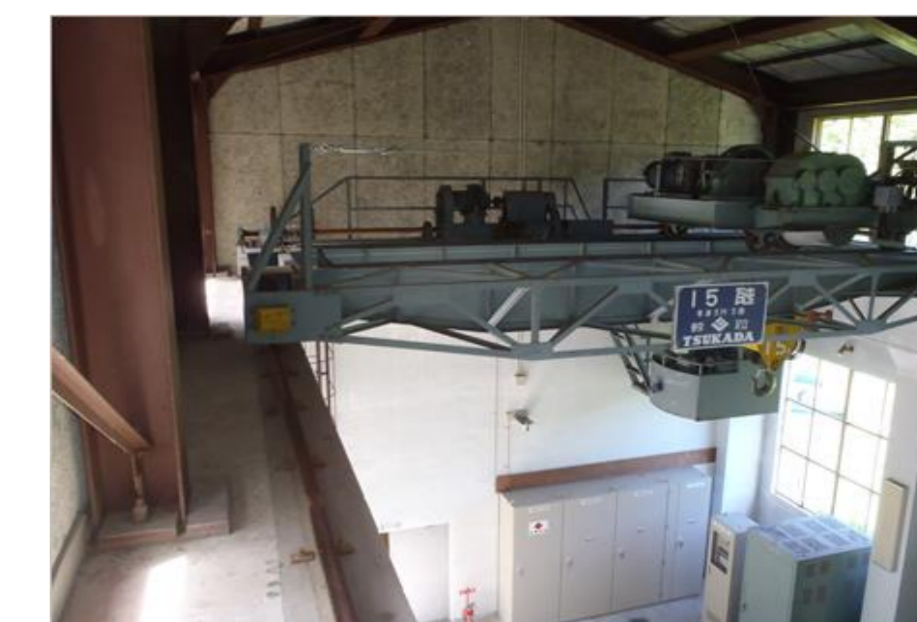
三隅川発電所天井クレーン（運転士資格要）
