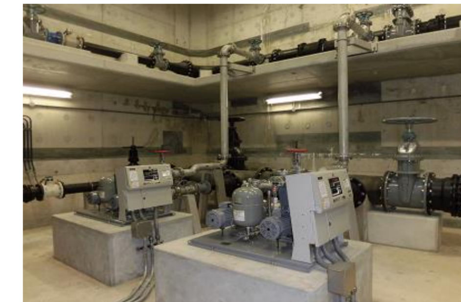
工業用水送水ポンプ(江津浄水場)
