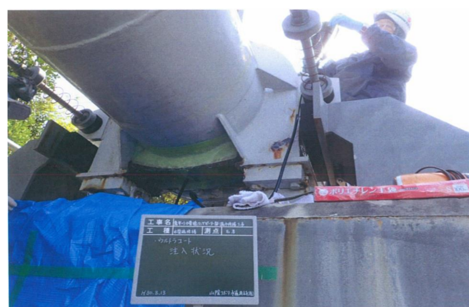
意宇川水管橋支承部修繕
