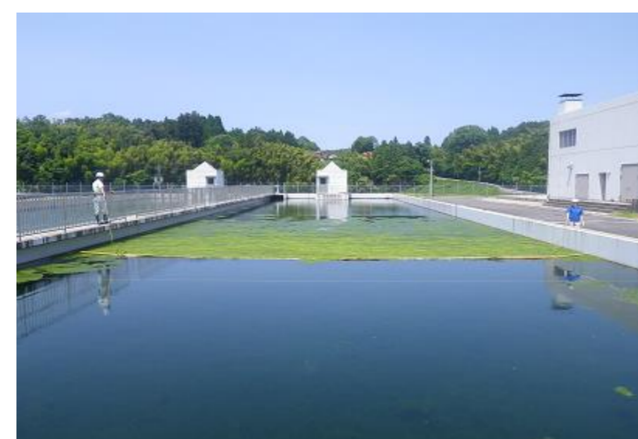
ろ過池藻類除去作業 (斐伊川)
