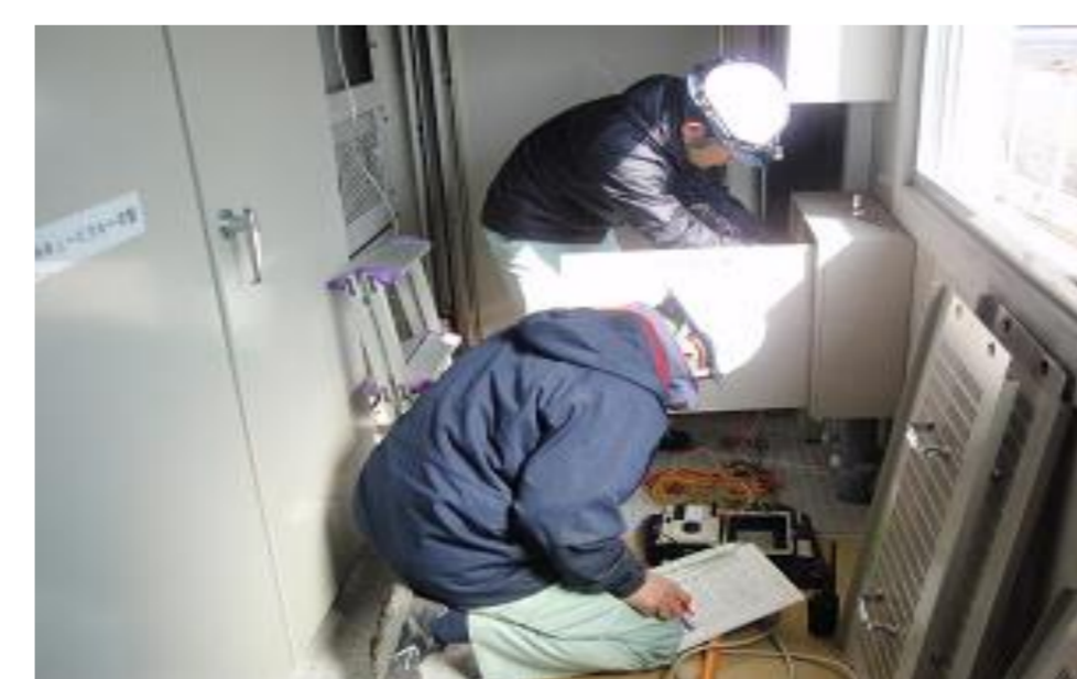
停電作業(今津浄水場)
