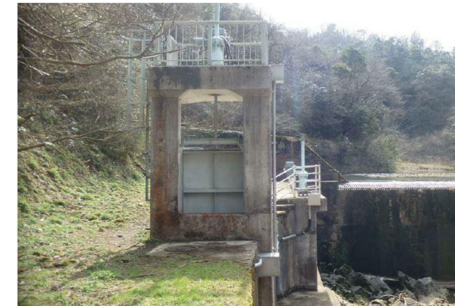
勝地発電所取水ロゲート
