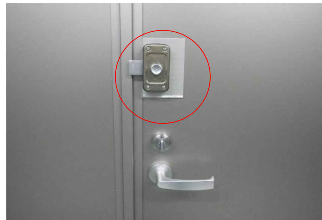
北稜町 追塩装置建屋鍵の二重化(建屋内側)
