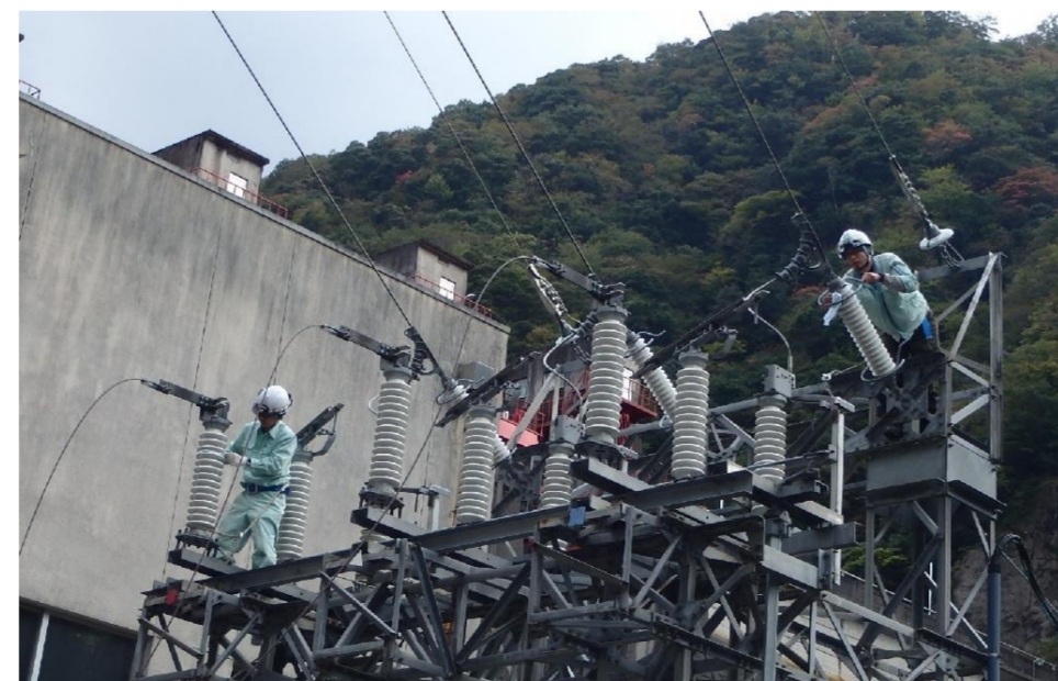
八戸川第二発電所停電作業
