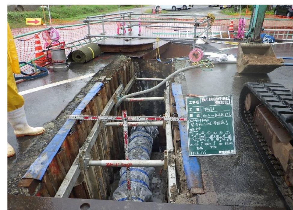
飯梨川工水送水管 揖屋地区布設替工事
