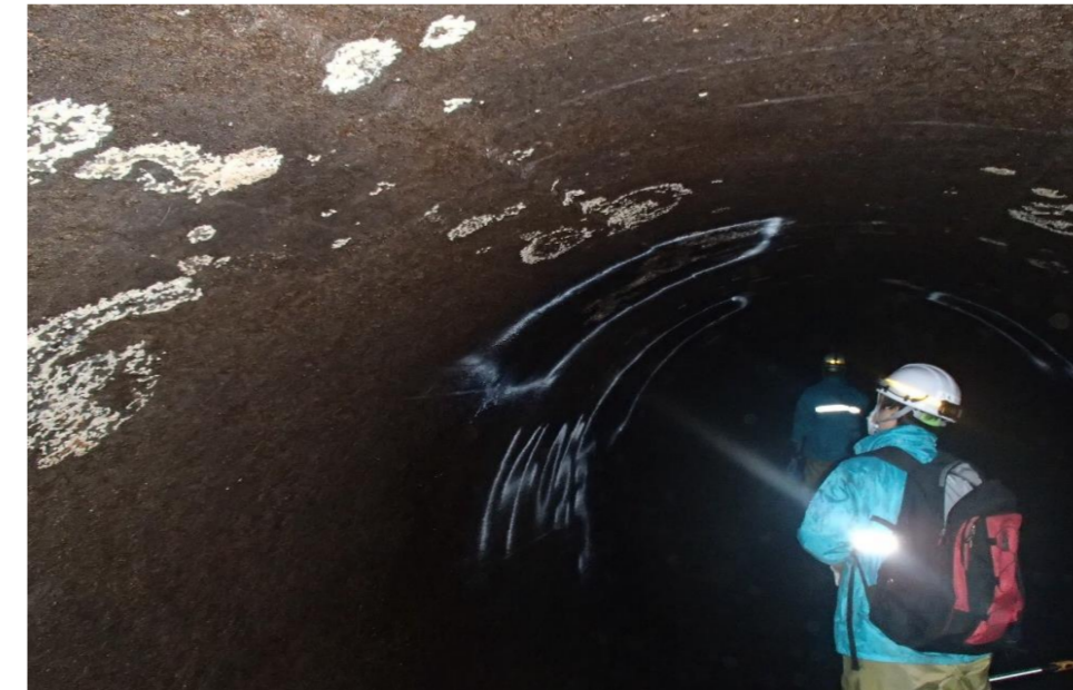
三隅川発電所隧道内部点検
