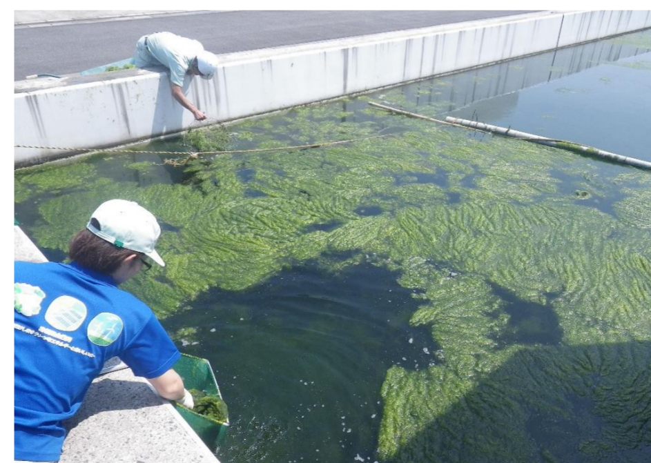
斐伊川浄水場の藻の除去作業
