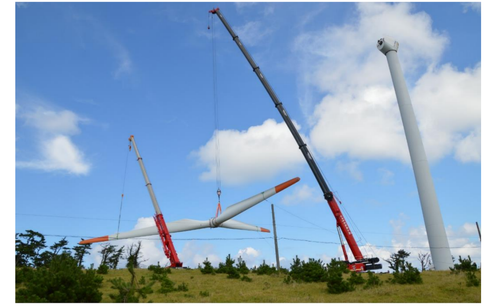
隠岐大峯山3号機撤去
