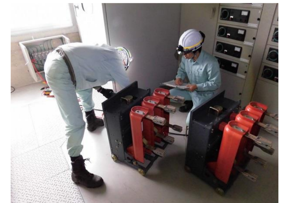
江の川浄水場停電作業
