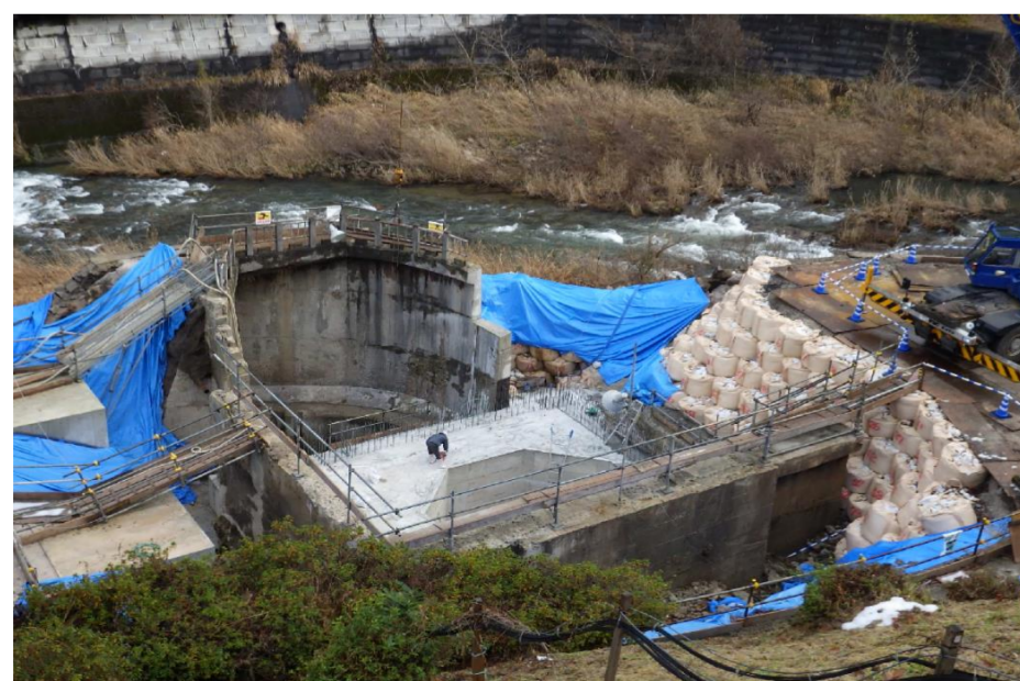
三成発電所リニューアル工事
