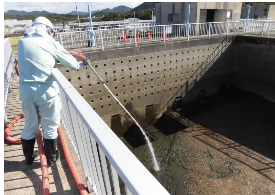
江の川浄水場沈澱池清掃
