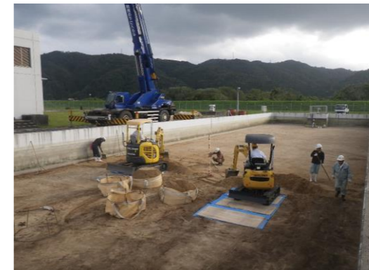
ろ過池補砂工事(斐伊川)
