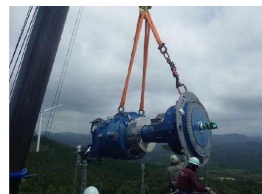
高野山風力発電所5号機(主軸ベアリング故障 取替・調査)
