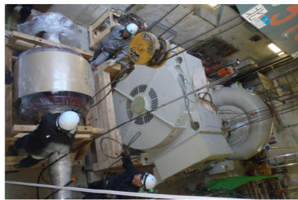
飯梨川第二発電所(リニューアル 工事)
