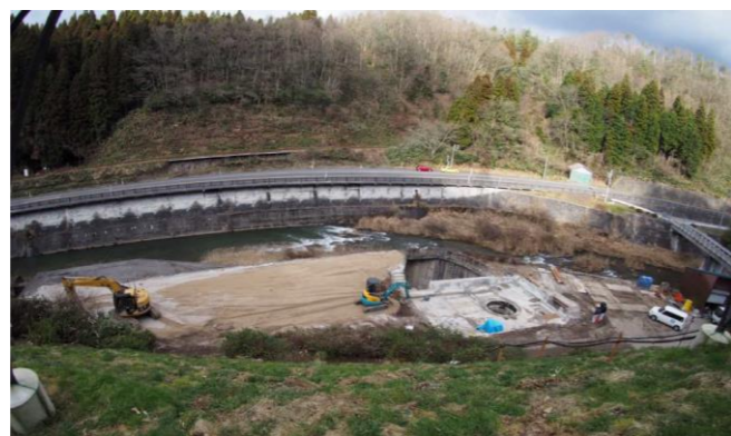
三成発電所(リニューアル 撤去)
