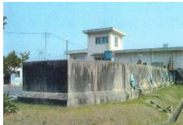
今津浄水場沈砂池
