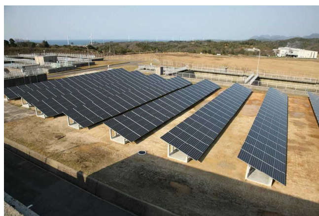
江津浄水場太陽光発電所
