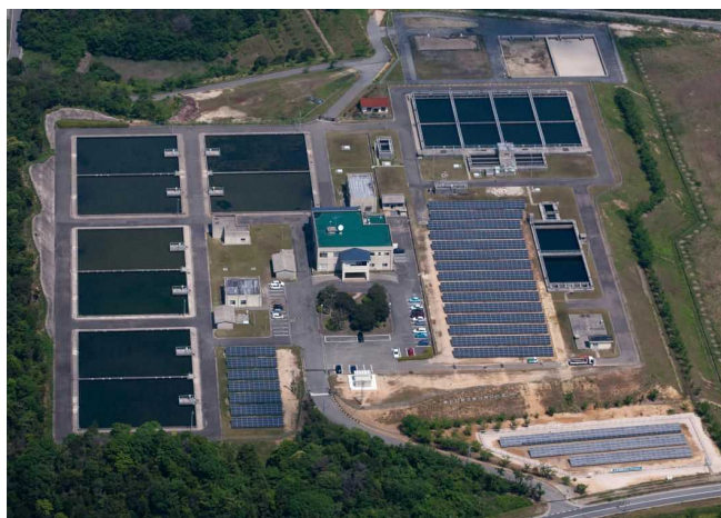
江の川水道 江津浄水場
