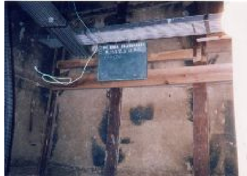
柱の座屈防止貫の設置
