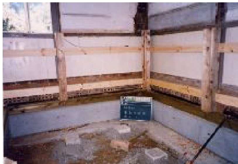
内部添え基礎・土台・添え柱設置
