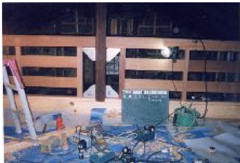
制振ダンパーの設置(1)
