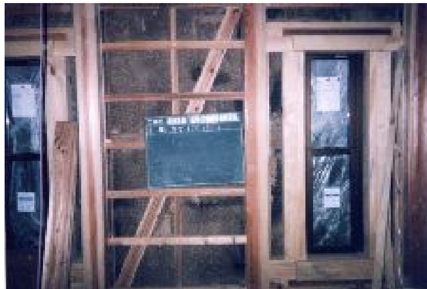
添え柱と筋交いの設置
