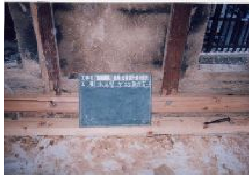
柱脚部の通し貫の設置
