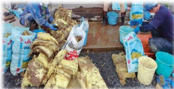
浸水したグラスウール
