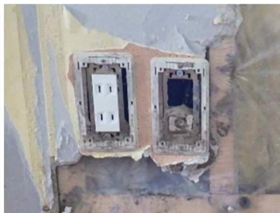
写真12：壁に設置されたコンセントボックス内に汚泥が残っている。
