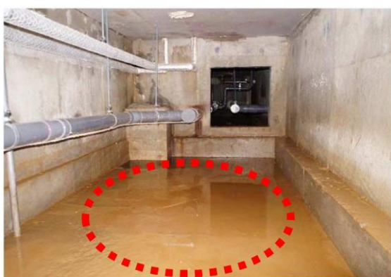
写真1：床下に汚泥と水がたまっており、床下空間が湿潤状態となっている。
