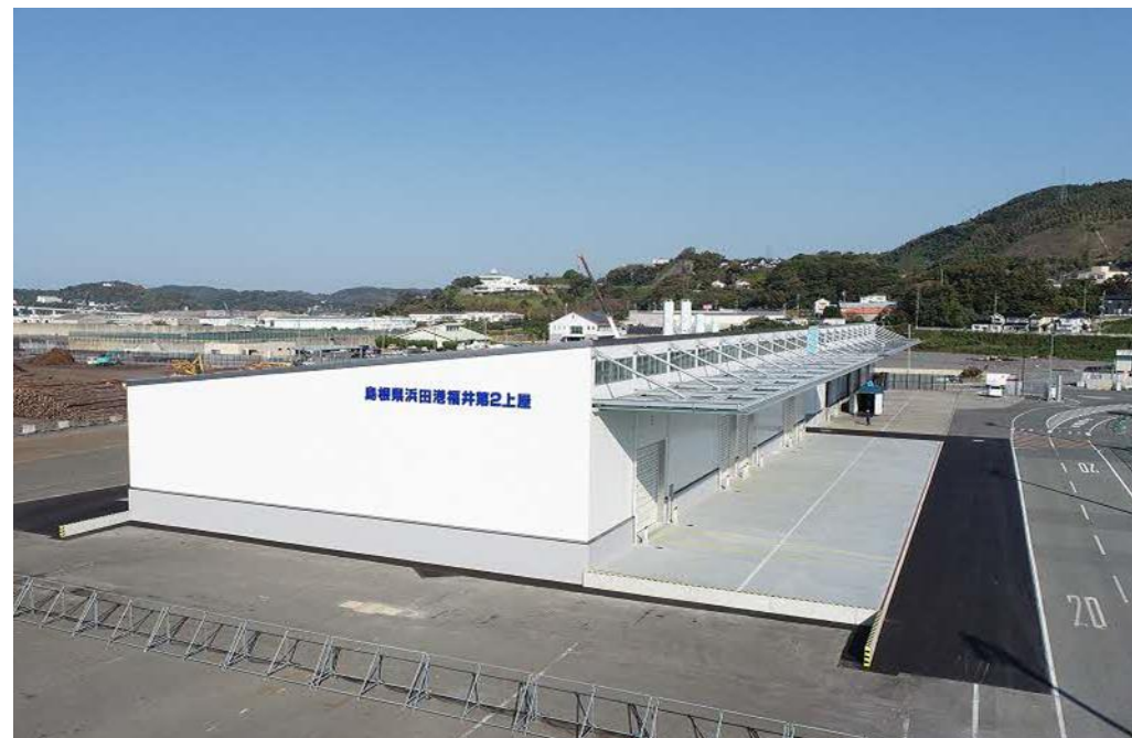
令和4年に完成した福井第2上屋
