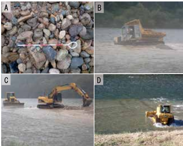
図 16. 2024 年の産卵場造成の作業の様子 A: 造成に使用した土砂, B: 造成範囲に土砂を運搬する作業 (10 月 23 日, 高い水位のため中断), C: 造成範囲内に土砂を広げる作業 (10 月 23 日), D: 砂抜きと均しの作業 (10 月 25 日)
