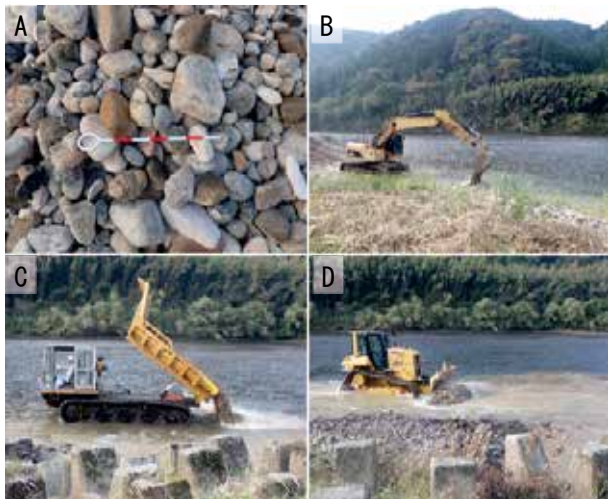
図 13. 2023 年の産卵場造成の作業の様子 A：造成に使用した土砂，B および C：造成範囲に土砂を投入する作業，D：砂抜きと均しの作業
