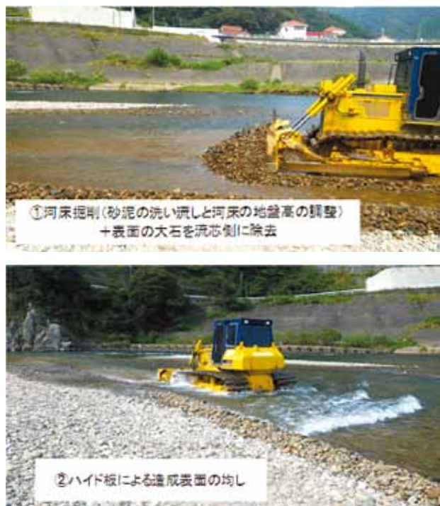
図8. 谷住郷の瀬. 本流側B区の造成状況
