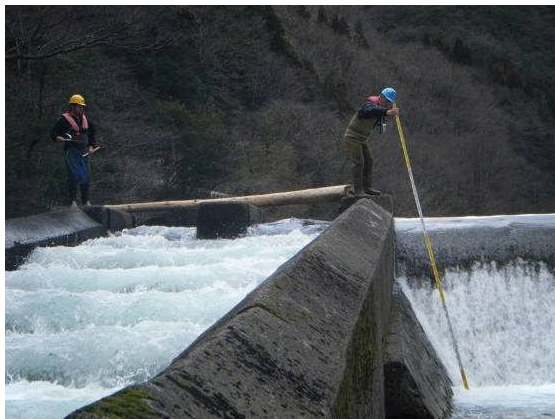
魚道上流側出口
