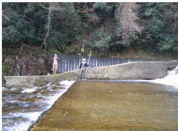
魚道 側面から
