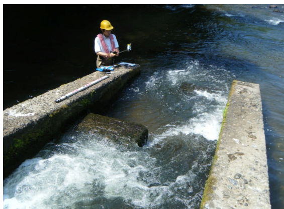
魚道内の流況
