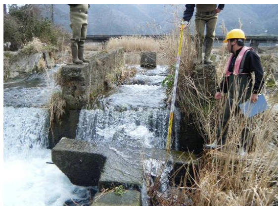
コンクリートタタキ下の段差(魚道入り口)
