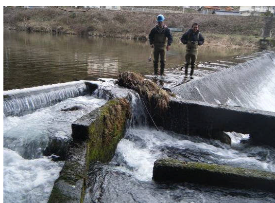
魚道上流側出口(堰板)
