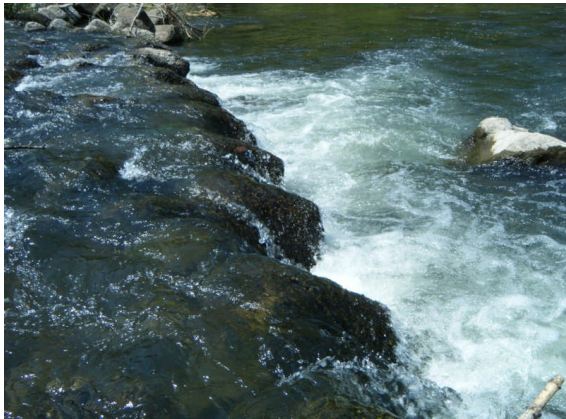
ブロック積みの段差
