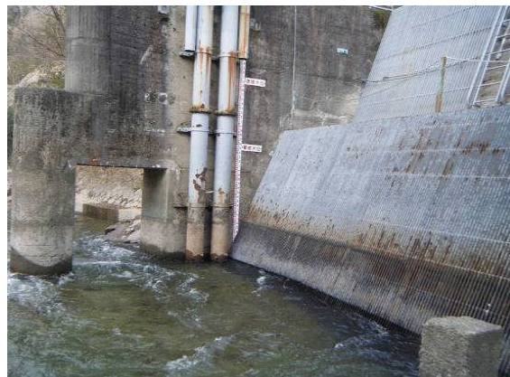
堰堤左岸の発電用取水口
