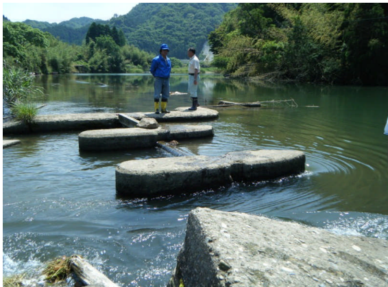
上流部のコンクリート水路
