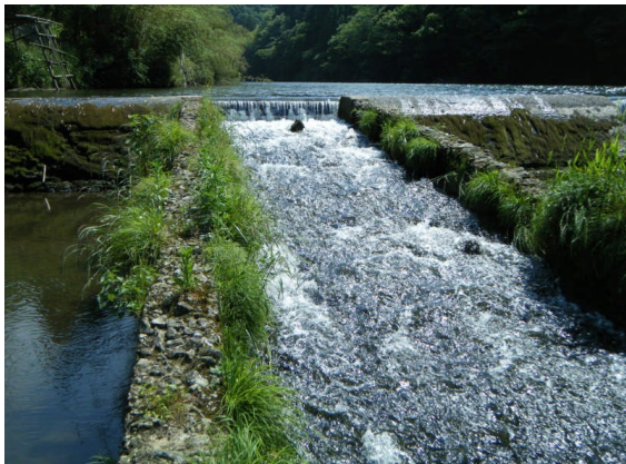
右岸側の魚道
