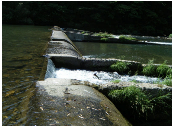
右岸側の魚道 最上部の落差
