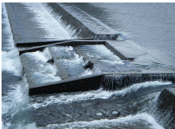
魚道(左岸側より)
