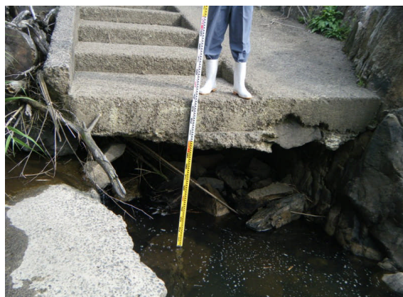
破損した魚道
