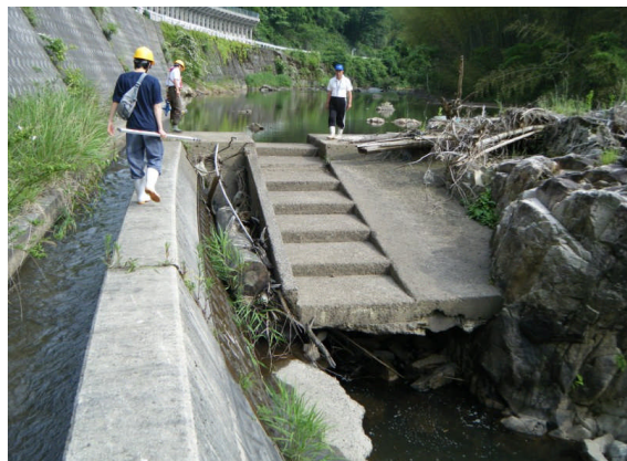
破損した魚道(右岸)
