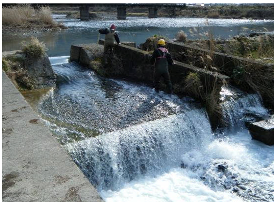
コンクリートタタキ下の段差
