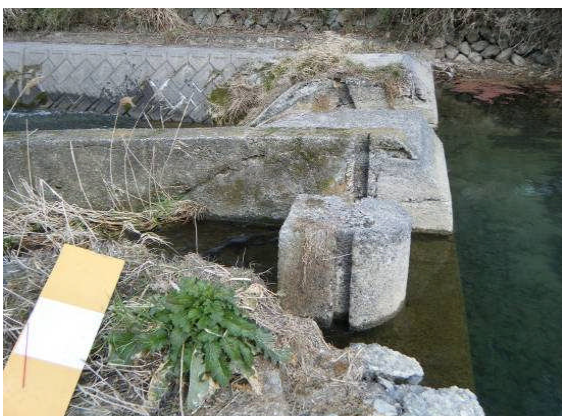
魚道上流側出口
