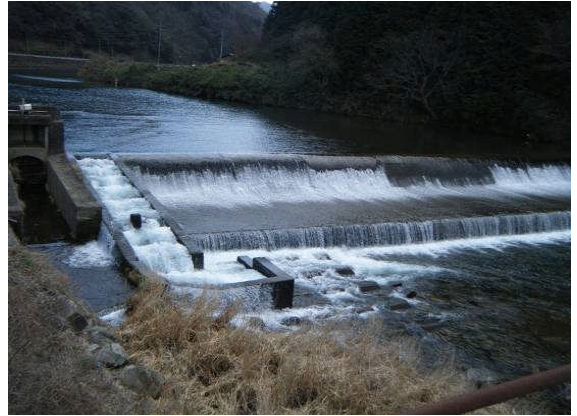
堰堤全景(下流側から)
