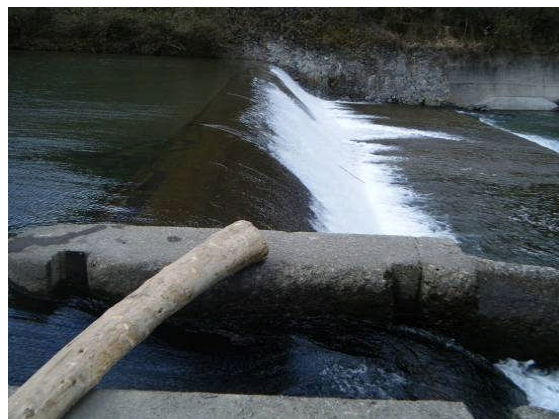
堰堤越流部の状況
