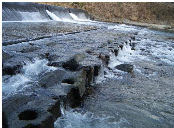
堰堤下のコンクリートブロック
