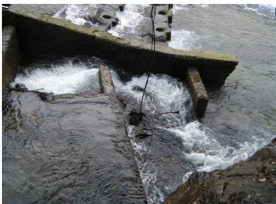
魚道の最下段(破損している)
