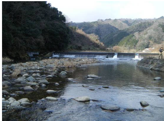
堰堤 下流側から
