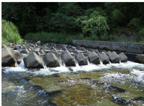
コンクリートブロックの段差
