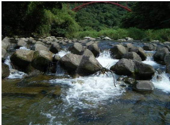
コンクリートブロックの段差
