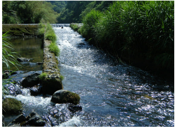
右岸側の魚道
