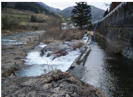
魚道上流側出口(取水路から流入)
