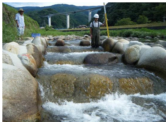
魚道内の流況
