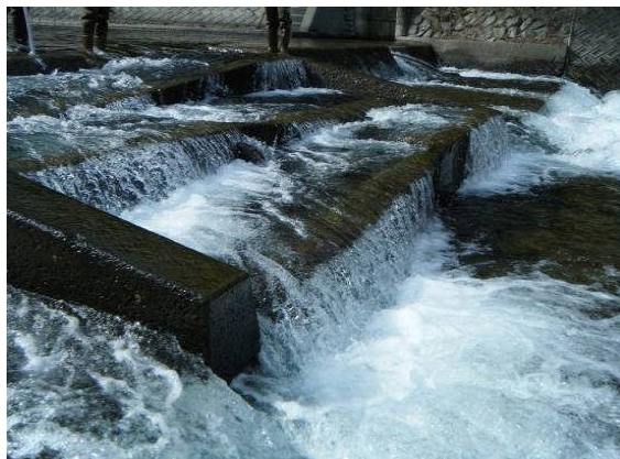
魚道 最下段の段差
