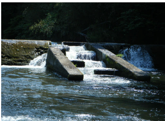
左岸側の魚道
