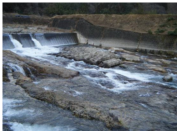
堰堤下の状況
