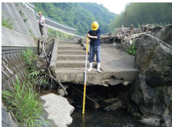
破損した魚道
