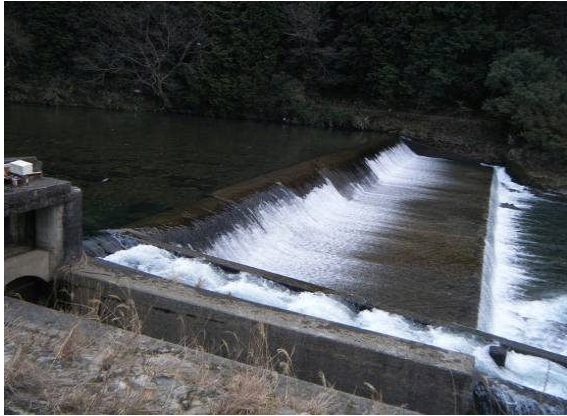
堰堤全景(右岸側から)
