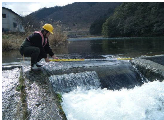
魚道上流部出口
