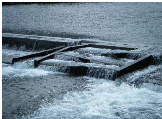
魚道(下流側より)
