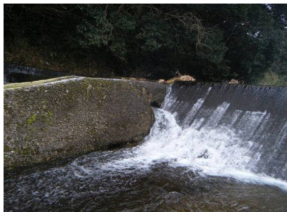
魚道(側面に穴が開いている)
