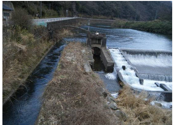
右岸側の用水路と魚道
