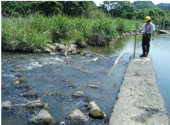
上流部のコンクリート構築物
