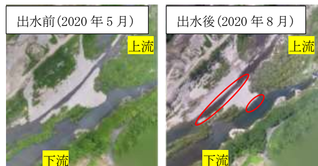
図2 2019年12月に施工した置土の出水前後の状態(赤丸で囲った部分は土砂が流出した箇所)
