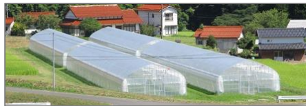
〔新設され営農開始を待つリースハウス〕
