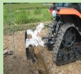
【弾丸暗渠の施工】
