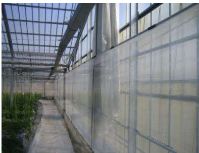
妻面のカーテンの隙間対策①
