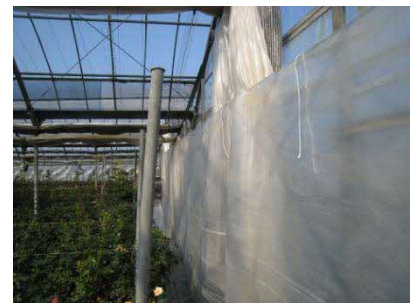
妻面のカーテンの隙間対策②
