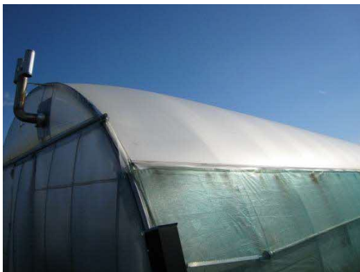
空気膜2重被覆（屋根部）
