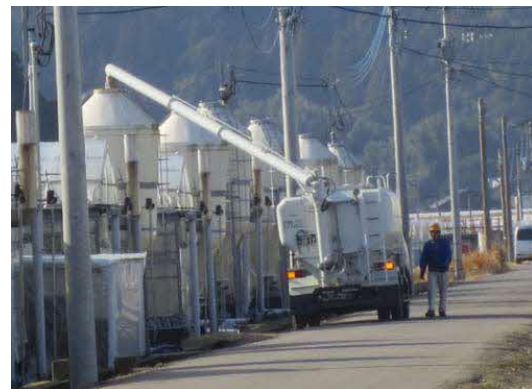
貯蔵タンクへの燃料の投入
