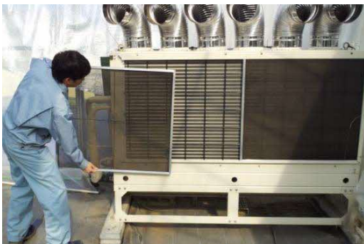
エアフィルターを取り外す
