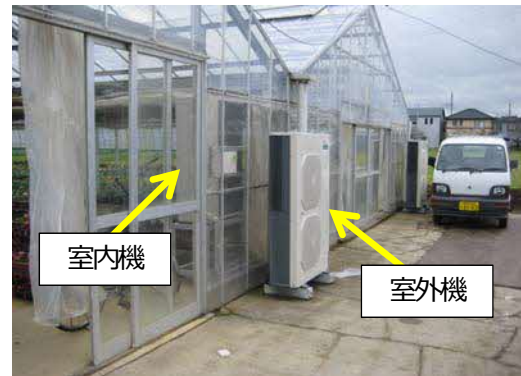
室内機と室外機の適切な設置例
