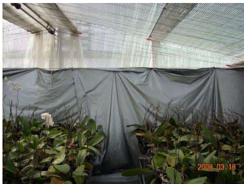
温室北面へ断熱資材を固定張り
