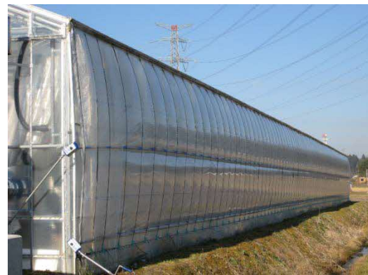
空気膜2重被覆（側面部）
