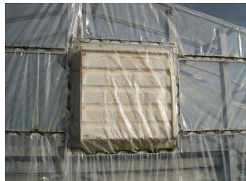
換気扇のシャッターを目張り
