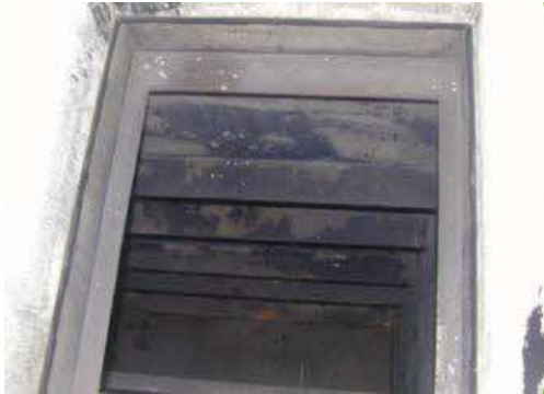
腐食抑制剤を使用している缶体
