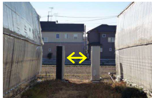
室外機の不適切な設置の例（ショートサーキットが発生しやすい）
