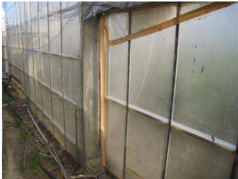
外張被覆の隙間を目張り
