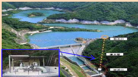
農業用ダムの落差を活用した小水力発電
