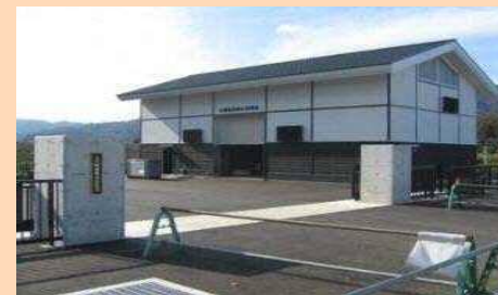
管路の圧力を活用した小水力発電
