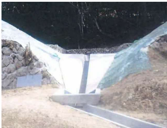
写真-4.5.4 急流工の設置事例
