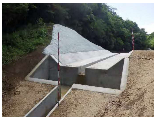
写真-4.5.3 接続桝の設置事例
