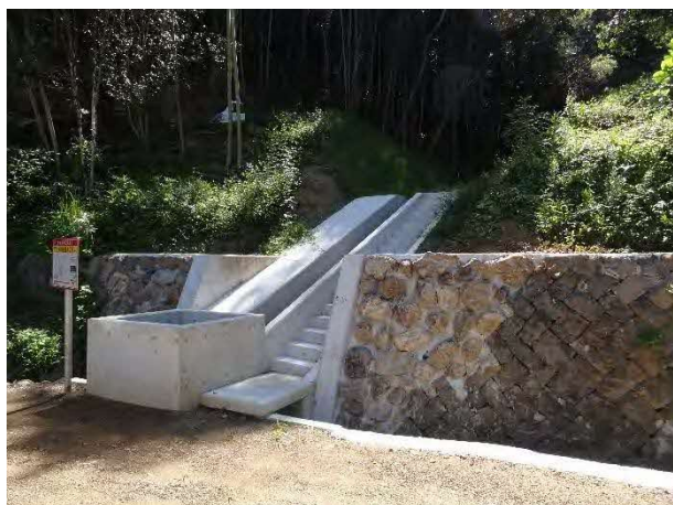
写真-4.5.5 擁壁、承水路の設置事例
