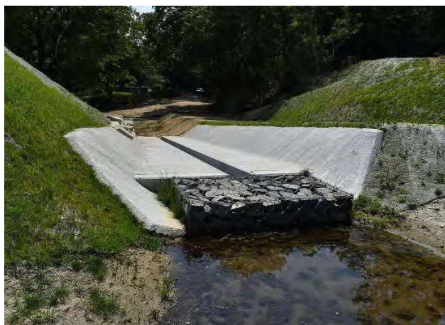
写真-7.1 生物の生息空間として一部水域を残す環境配慮の事例
