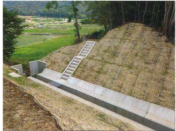
写真-4. 5. 6 階段工の設置事例
