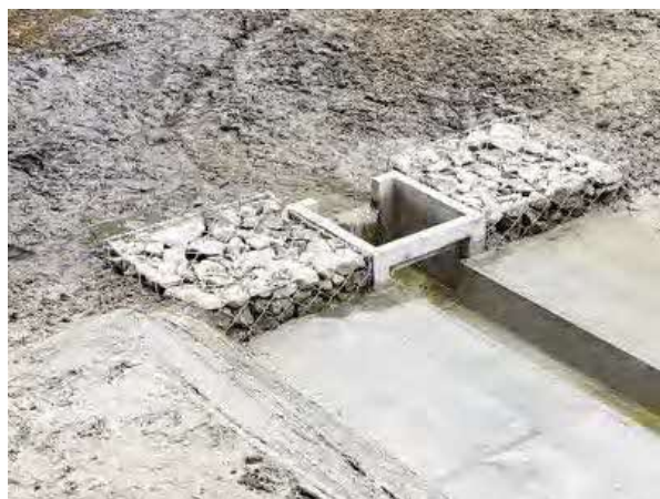
写真-4.5.2 集水樹の設置事例
