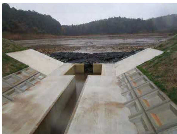
写真-4.5.2 集水樹の設置事例
