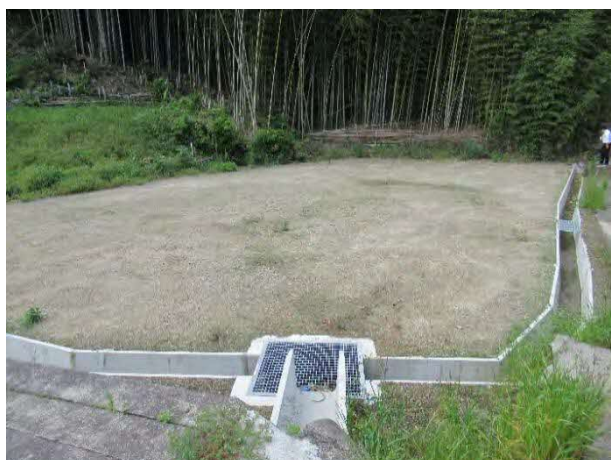
写真-3.5 埋立工法によるため池の廃止事例1
