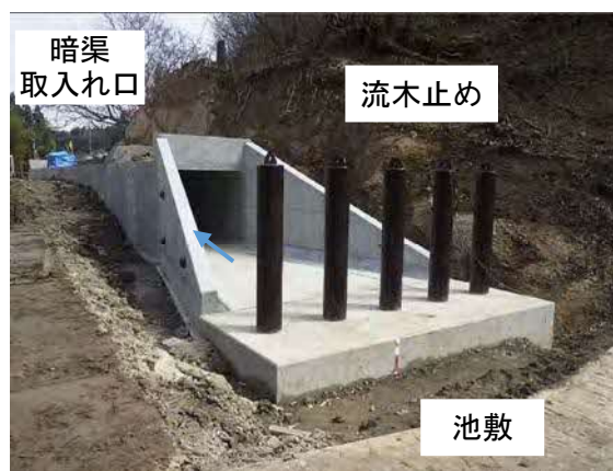
写真-5.3.1 暗渠上流側の流木止め設置例
