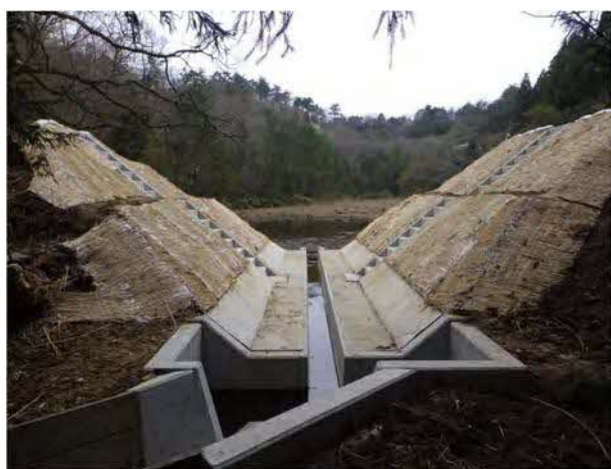
写真-4.5.3 接続桝の設置事例
