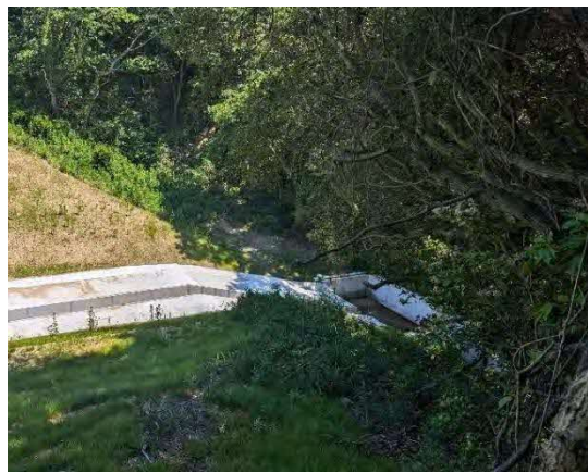
写真-4.5.4 急流工の設置事例
