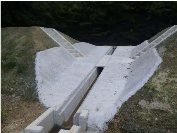
写真-4. 5. 6 階段工の設置事例
