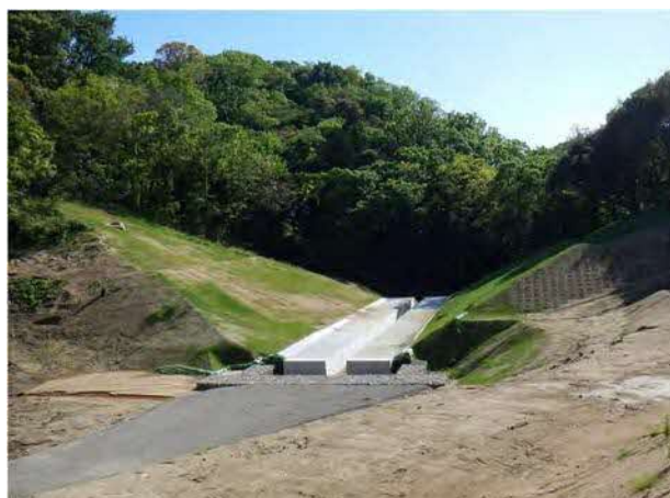
写真-3.1 開削工法によるため池の廃止事例1
