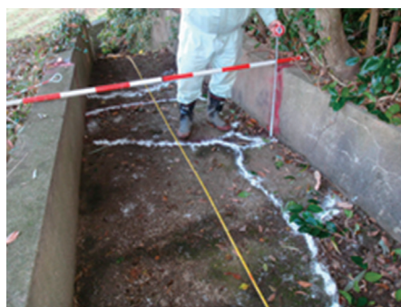
放流部底版コンクリート剥離及び側壁クラック状況
