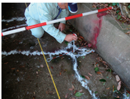
放流部底版コンクリート剥離及び側壁クラック状況
