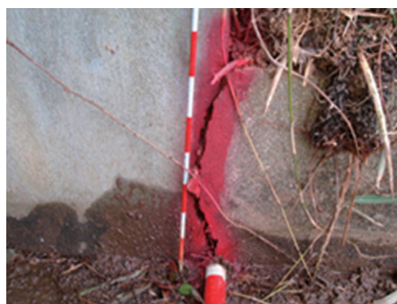
放流部底版コンクリート剥離及び側壁クラック状況
