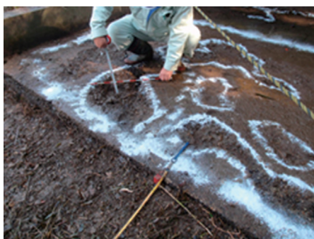
放流部底版コンクリート剥離及び側壁クラック状況
