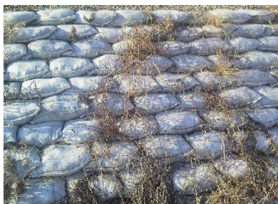
土のうによる漏水防止対策
