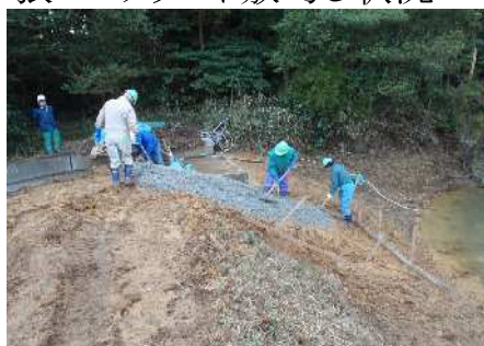
張コンクリート敷均し状況
