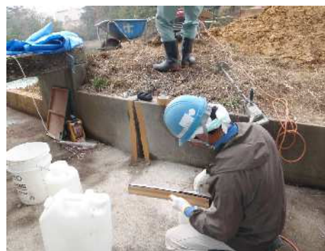
接着用エポキシ樹脂塗布
