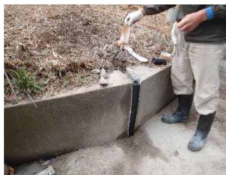
目地材(TMライナー)設置状況
