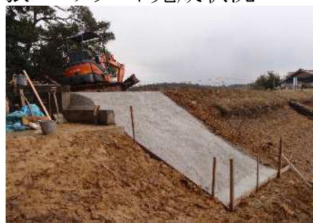
張コンクリート完成状況
