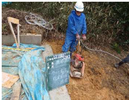
埋戻締固め状況
