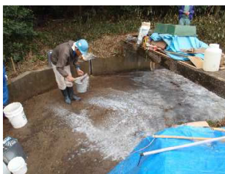
下地プライマー塗布状況
