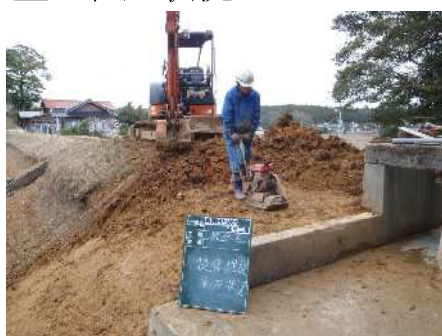
盛土転圧状況
