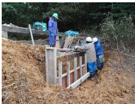
型枠施工状況
