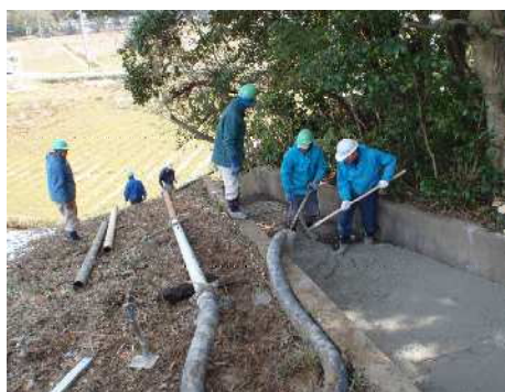
コンクリート打設状況
