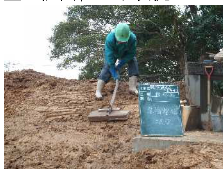
盛土法面仕上げ状況
