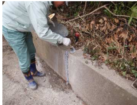
アクリル系プライマー塗布状況
