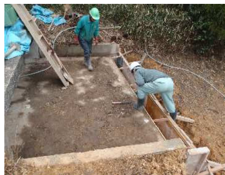
型枠施工状況
