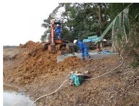
カットオフ埋戻 バックホウ投入・人力まき 出し状況
