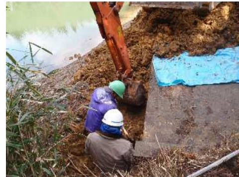
人力による床堀状況
