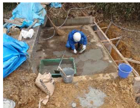
底版コンクリート欠損部分のモルタル充填状況
