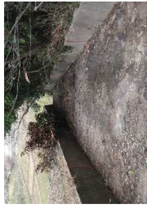
余水吐急流部の状況
