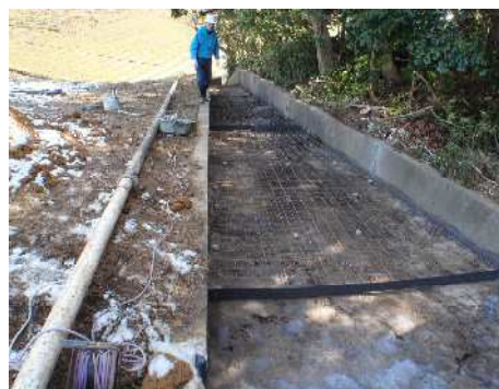
目地板及び鉄筋金網(D6)設置状況
