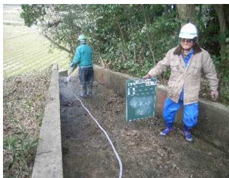
底版コンクリート面の洗浄状況
