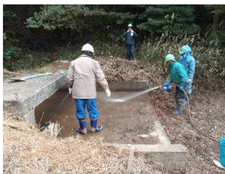
底版コンクリート面の洗浄状況
