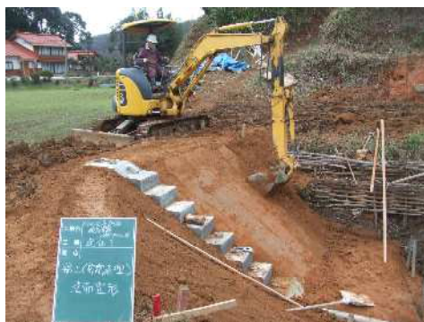
盛土法面仕上状況
