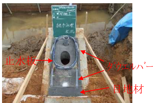
⑦斜樋:継手材設置状況
