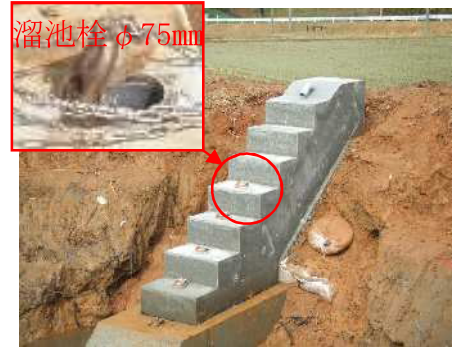
⑪斜樋:完成
