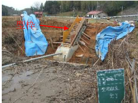
⑩斜樋:型枠状況
