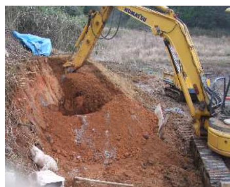
セメント混合状況
