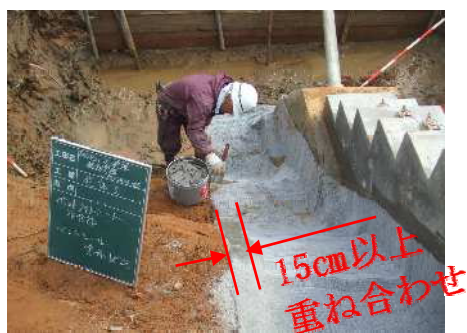
ベントナイト系遮水シート同士の接着剤(ベントシル)塗布状況
