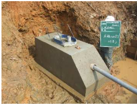
⑤底樋取付:完成
