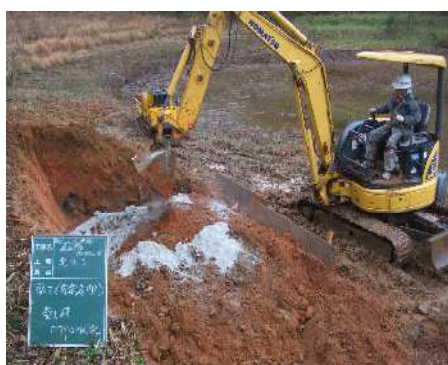
セメント混合状況
