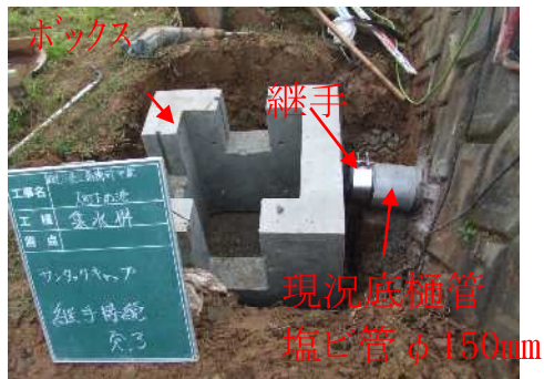
⑫管理柵:ボックス、継手材設置状況
