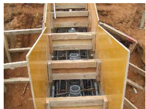
⑨斜樋:取水孔VP管φ75mm設置状況
