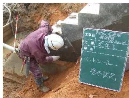
構造物の接着剤(ベントシル)塗布状況
