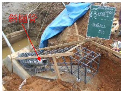
⑧斜樋:VP管φ150、鉄筋組立状況
