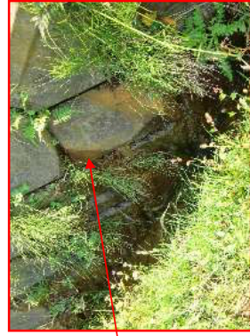
下流法先ブロック(空積)の状況
