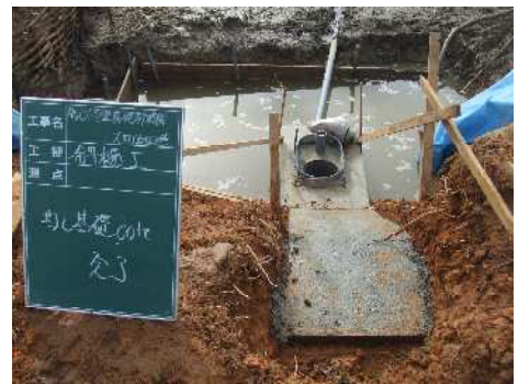
⑥斜樋:基礎コンクリート状況
