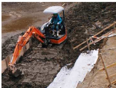
まき出し・敷均し状況
