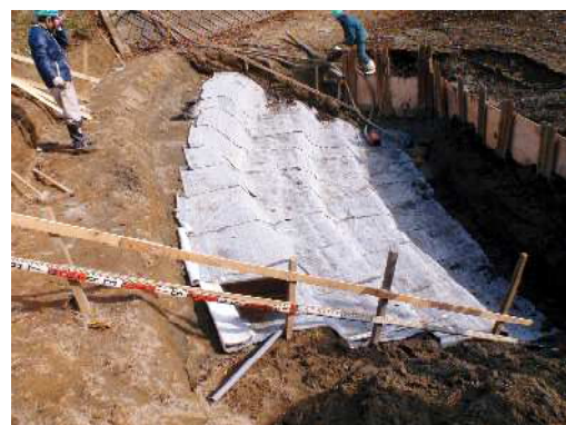
シート敷設状況
