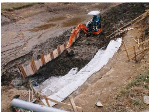
まき出し・敷均し状況
