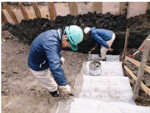
接着剤(粒状ベントナイト)塗布状況
