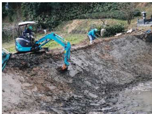
盛土法面仕上状況
