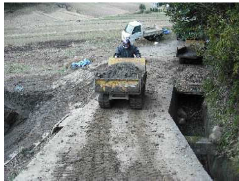
盛土部へ運搬状況
