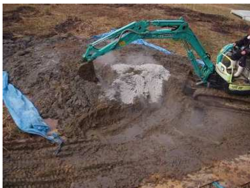
セメント安定処理(散布・混合)状況
