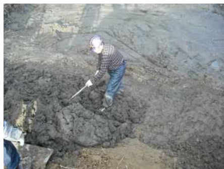
まき出し・敷均し状況
