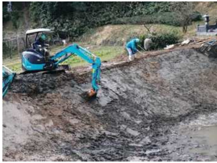
盛土法面仕上作業
