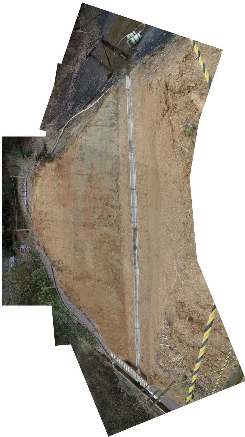
堤体切開・洪水吐放水路
