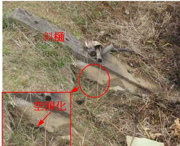
下流側法止ブロック状況(斜樋廻りからの漏水)
