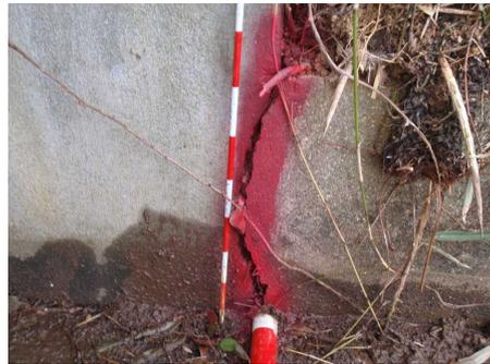
放流部底版コンクリート剥離及び側壁クラック状況
