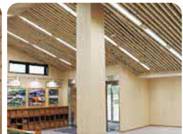
三瓶自然館サヒメル 新館天井材
