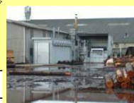
木くず焚きボイラー 木材乾燥機
