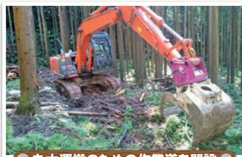
丸太運搬のための作業道を開設
