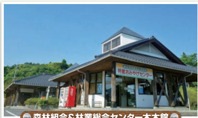
森林組合&林業総合センター木木館
