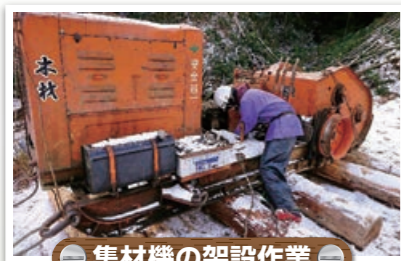
集材機の架設作業
