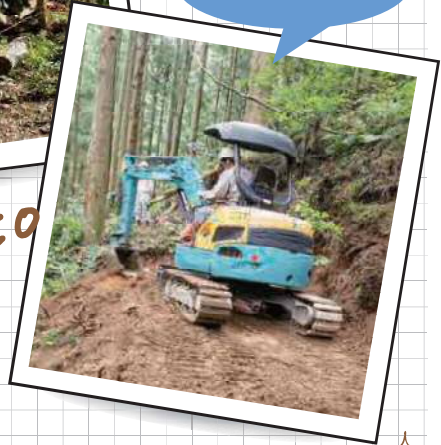
作業道の作設中
