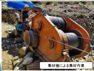
集材機による集材作業
