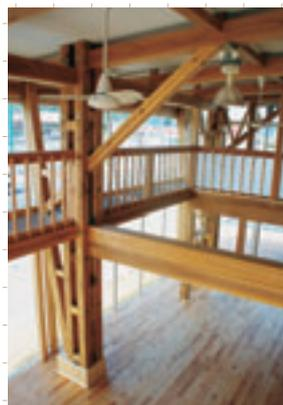
スギ材の「合わせ梁」と「組み柱」、マツ材フローリング
