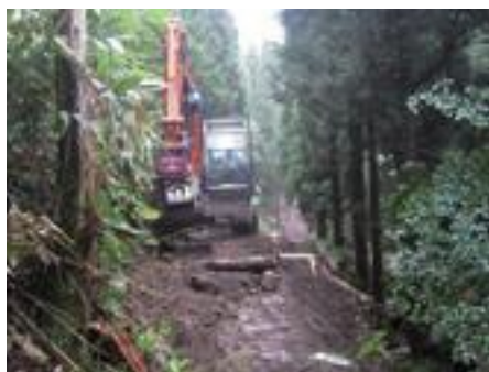
路網設計・施工技術研修
