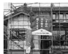
■県産木材を使用した木造住宅
