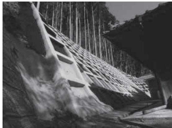
山腹工事：法枠工などによる山崩れ対策
