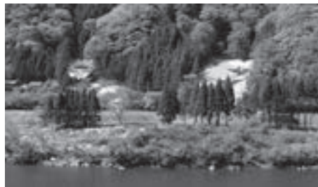
【谷止工群による国道・人家の保全】
