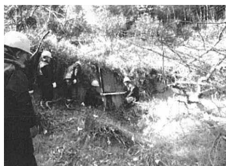
住民との治山施設点検
