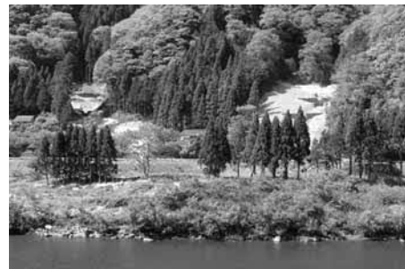
谷止工群による国道・人家の保全
