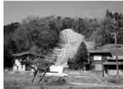
治山施設（山腹工）
