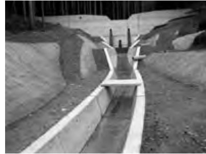
谷止工、 流路工
