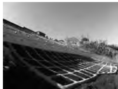
アンカー工、 法枠工
