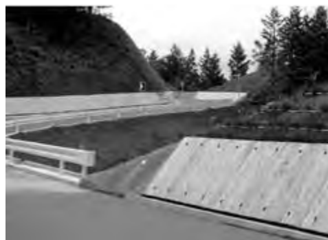
〔法尻に間伐材を使用した間伐パネル〕
