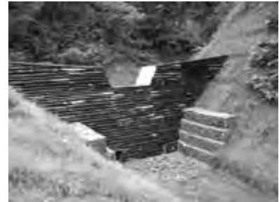
治山施設（治山ダム工）
