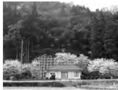
土留工、 法枠工
