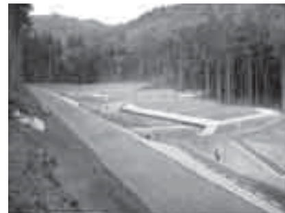
治山ダム工の築設状況
