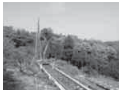
杭打工 (施工中)
