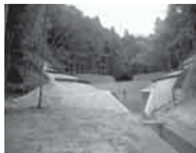
谷止工、 流路工
