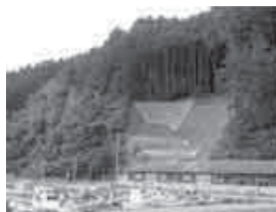
土留工、 法枠工
