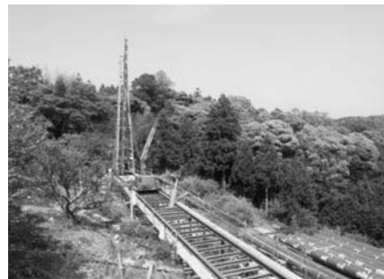
杭打工 (施工中)
