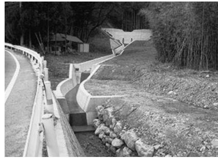
谷止工、 流路工
