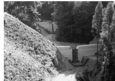
治山ダム工の築設状況
